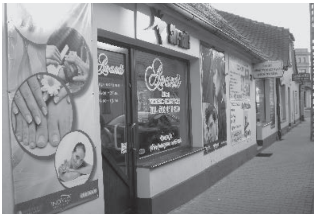
IL. 1 Domy nikające w gąszczu reklam - fragment zabudowań przy ul. Dworcowej w Pniewach (fot. W. Bryl-Roman - 2013)
